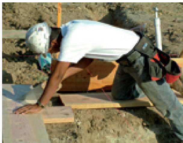
Obrero con casco, uno de los sistemas de protección más extendidos y eficaces.
